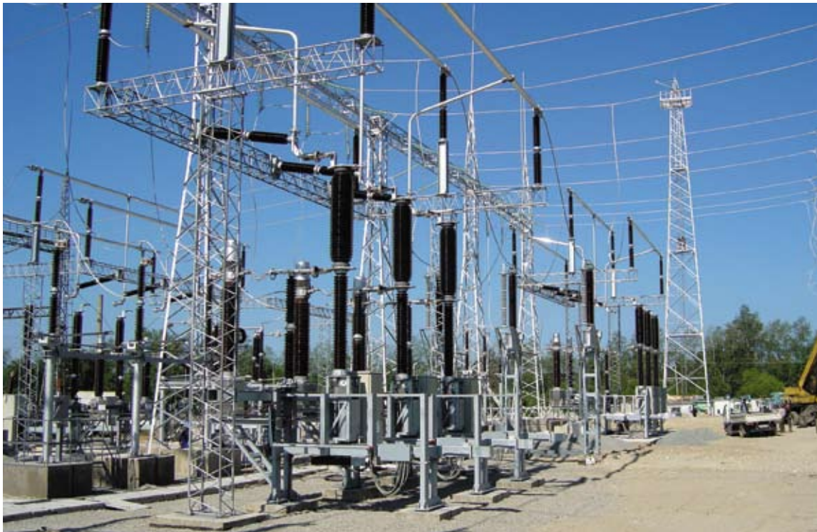
В «Гидроэлектромонтаже» умеют «оживить» оборудование, простоявшее без ввода в работу почти 15 лет.
