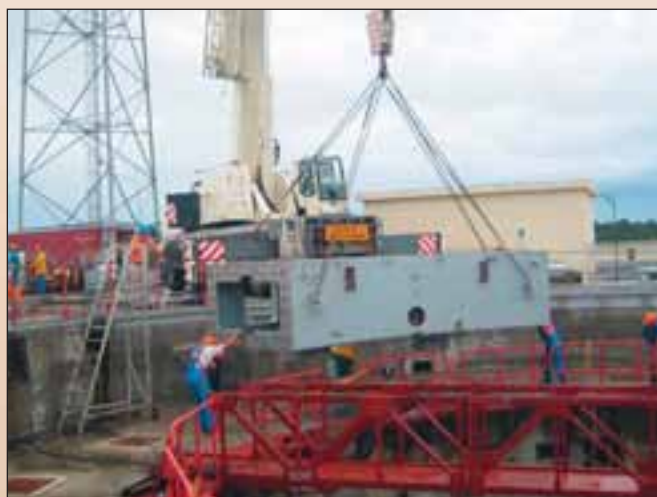
Монтаж первого сектора опорного кольца стартовой системы
