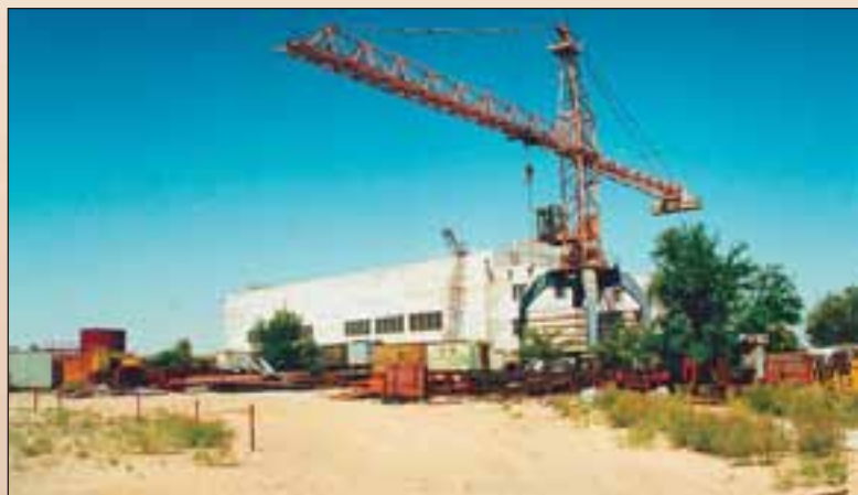
Цех сборки металлоконструкций и оборудования на промбазе треста (площадка 19А)
