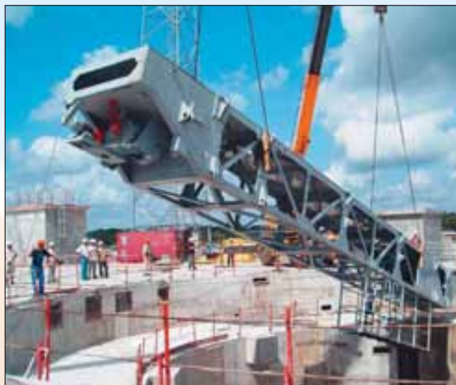
Монтаж поперечной балки кабины обслуживания
