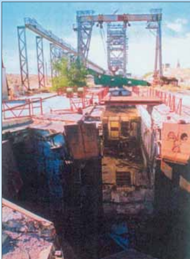
Подъемно-козловое устройство грузоподъемностью 160 т на разборке стартового сооружения на площадке 200
