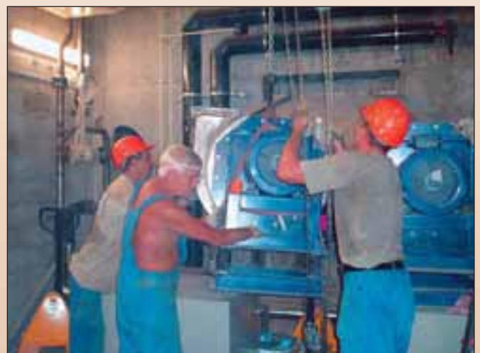
Сборка системы термостатирования
