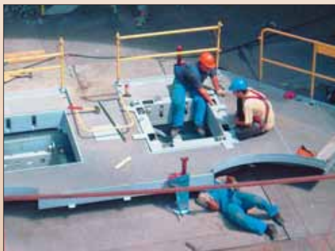
Монтаж кабины обслуживания
