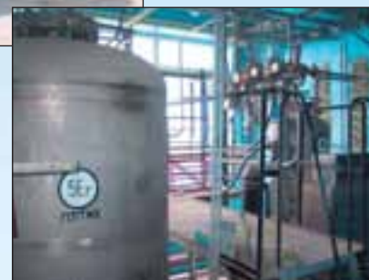
Монтаж хранилища горючего
