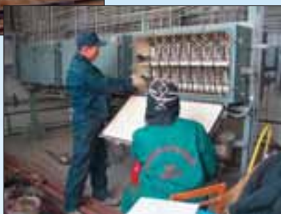
Монтаж щита управления заправкой топливом космических аппаратов
