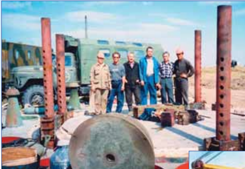
Подготовка к выемке защитной крыши («пробки») на командном пункте
