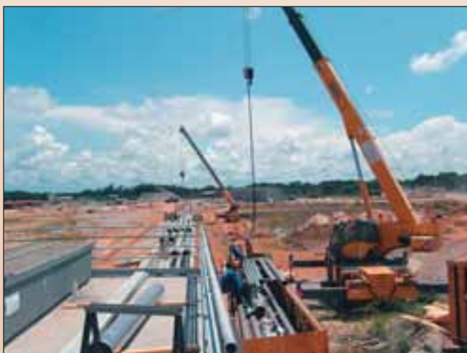
Монтаж трассы криогенных трубопроводов заправки ракеты-носителя жидким кислородом
