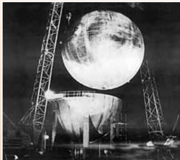
Такелаж криогенного резервуара объемом 1400 м 3 , массой 120 т
