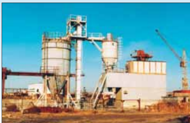
Бетонный завод на промбазе треста (производительность 20 м 3 бетона в час)
