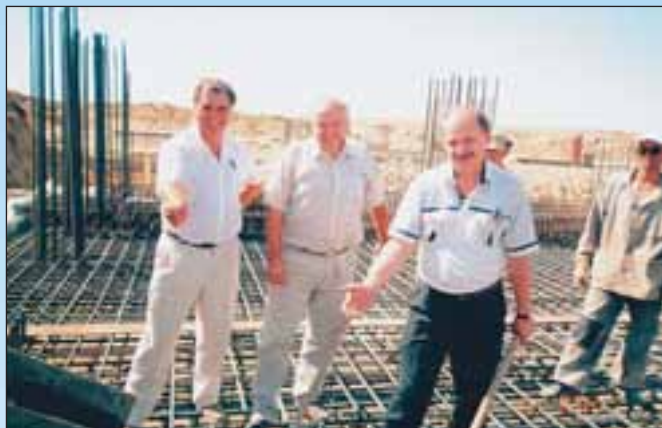
Подготовка к бетонированию фундамента сооружения 65 хранилища пероксида водорода на площадке 250А
