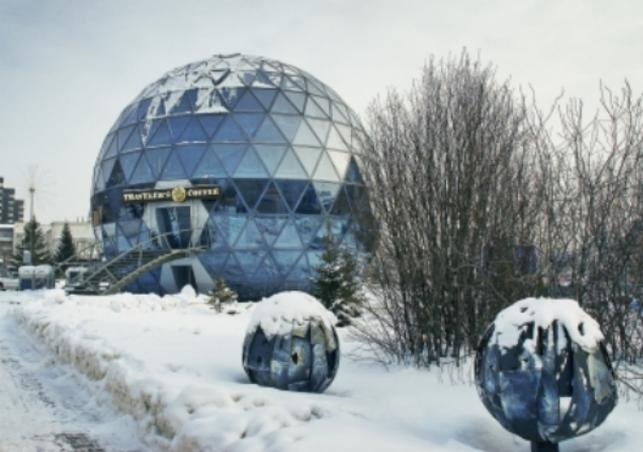
Изготовление стальных структурных конструкций SpaceStructure происходит с учетом всех существующих требований по качеству и дизайну, и отвечает современным технологическим условиям. Все узловые соединения прошли сертификационные испытания в научно-исследовательской лаборатории (РОСС RU.СГ43. Н01674, РСС RU.СЛ43.Н00032), запатентованы и внесены в государственный реестр РФ (№ 72708).
